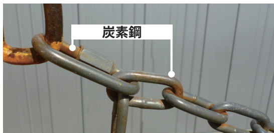
写真1 炭素鋼－炭素鋼 の組み合わせ
