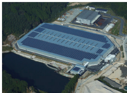
写真 2 CS 処分場 外観 （熊本県公共関与産業廃棄物管理型最終処分場「エコアくまもと」）
